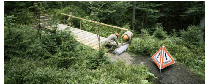
Ein Bachlauf kann Dank einer neuen Holzbrücke sicher überquert werden.
