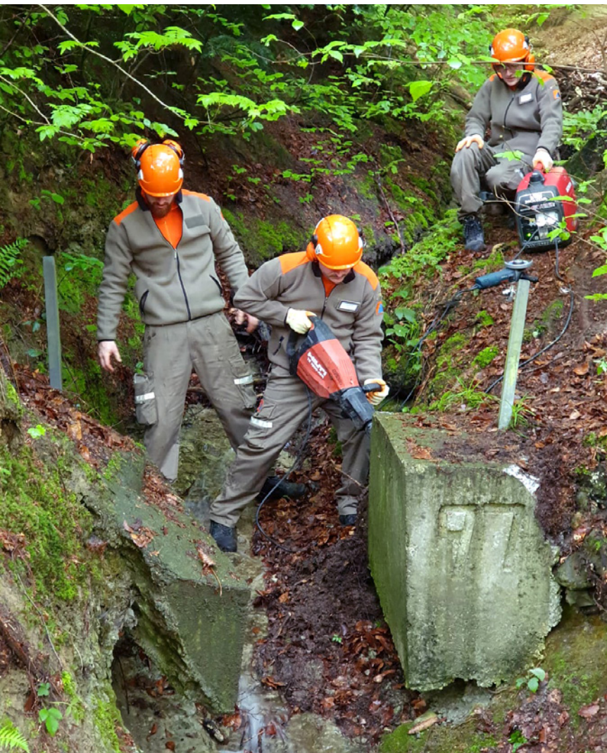
Abbruch von nicht mehr funktionsfähigen Bachverbauungen
