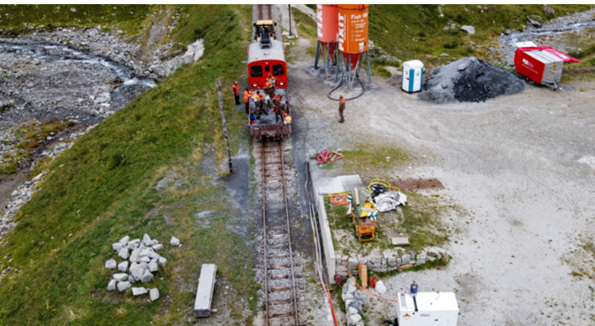
Die Schnelleinsatz-Formation leistete der DFB mit rund hundert Mann tatkräftige Unterstützung bei Sanierungs- und Unterhaltsarbeiten.
