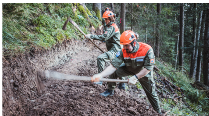
Wegausbau im Matsch und Schlamm
