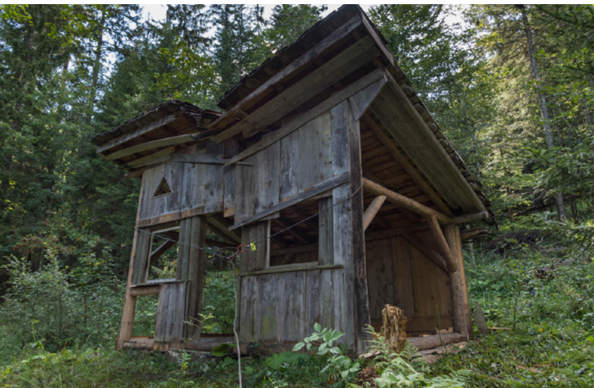
Abbruch der beschädigte Waldhütte
