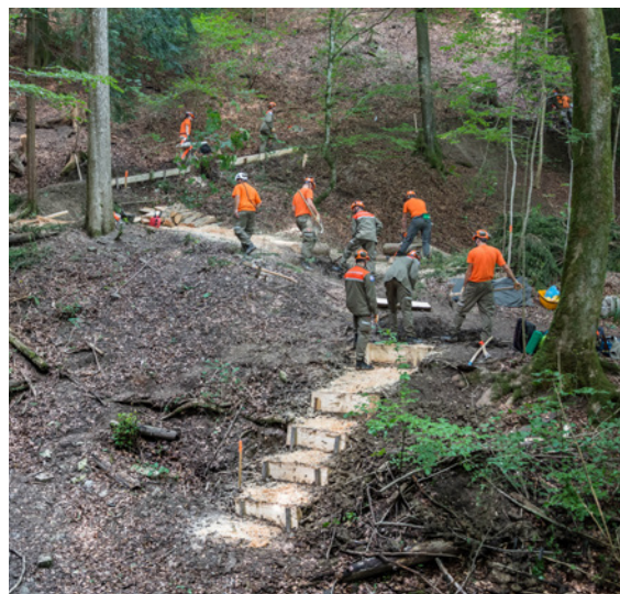
Neue Zugangswege im Schutzwald von Ennethorw
