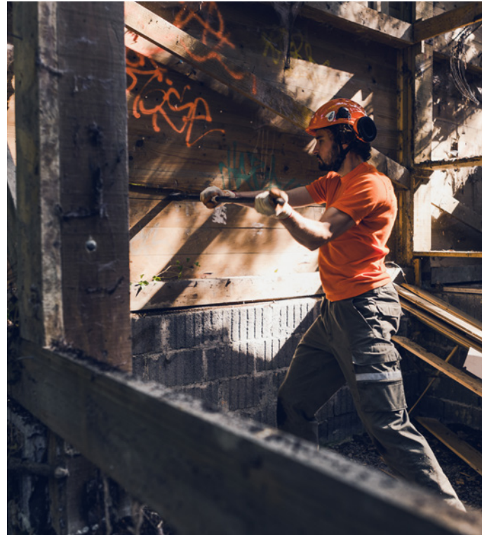
Abbruch einer alten Forsthütte bei Emmen durch die Cobra
