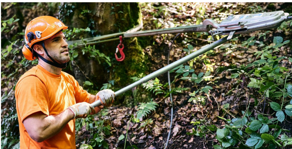
Bei den Räumungsarbeiten in Bachläufen kommen Seilzüge zum Einsatz.
