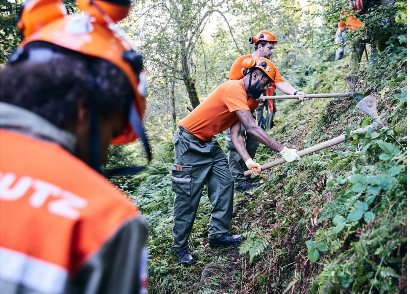
In steilem Gelände geht es oftmals nur mit Handarbeit vorwärts.
