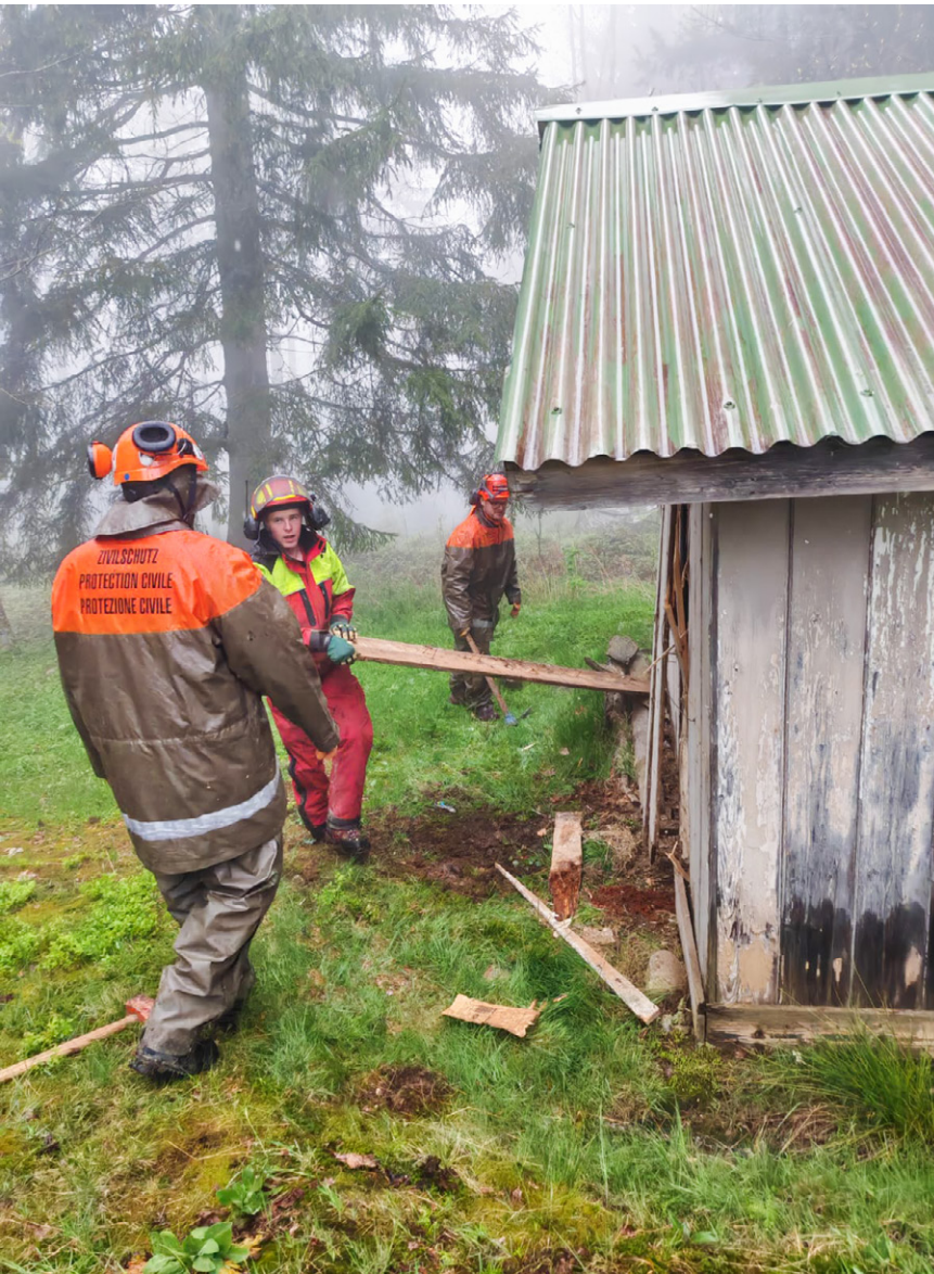
Diese Waldhütte wird nicht mehr benötigt und deshalb abgerissen.
